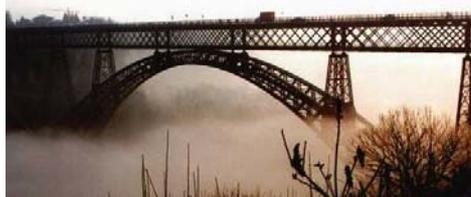
il ponte di Paderno d'Adda fu realizzato tra il 1887 e il 1889 utilizzando acciaio e ghisa con oltre 100'000 chiodi; su due livelli passano la strada e la ferrovia; la travata è di 255 m e la corda di circa 150; nelle immediate vicinanze si trovano le prime centrali elettriche d'Europa realizzate a fine 800 sfruttando il dislivello dell'Adda tra Paderno e Trezzo per alimentare le industrie di Milano Sesto S. Giovanni e Monza
